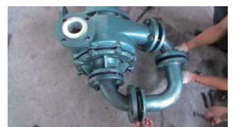
48. 安装弯头接管, 注意不要遗漏垫床, 逐一拧紧螺栓
