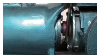
47. 对角均匀拧紧密封盒压盖上的紧固螺栓
