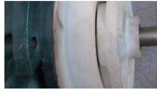
27. 检查一级叶轮与后泵盖之间的间隙 ※注②
