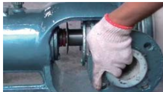
18. 装上装配好的吸入口三通接管组件
