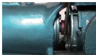
42. 对角均匀拧紧密封盒压盖上的紧固螺栓
