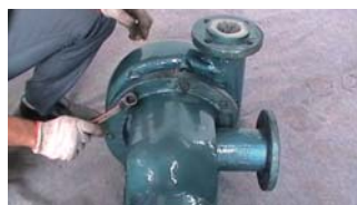
40. 对角均匀拧紧泵壳与轴承座的连接螺栓 ※注②
